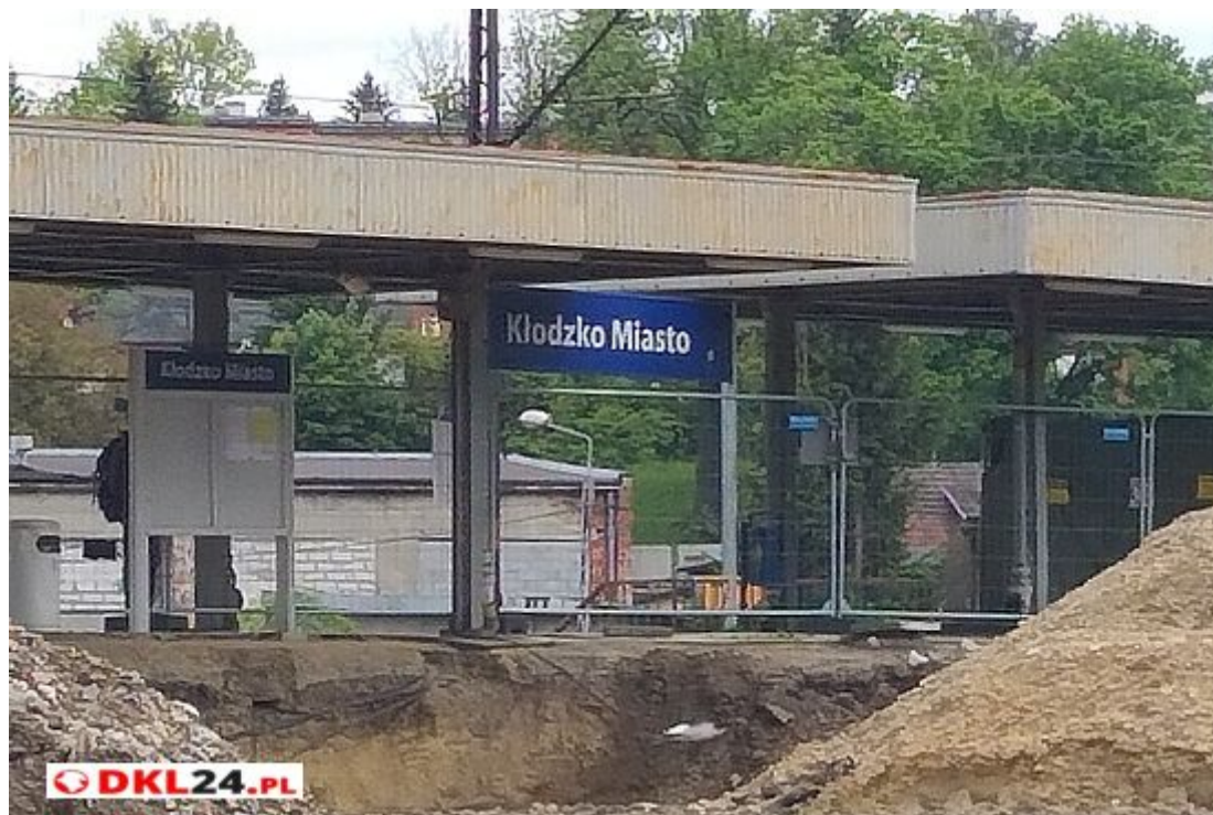
Na placu budowy przygotowuje się miejsca pod nowe perony
