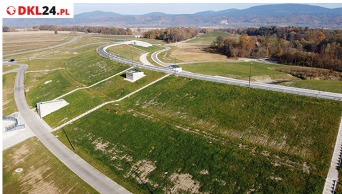
Suchy zbiornik przeciwpowodziowy w Roztokach
