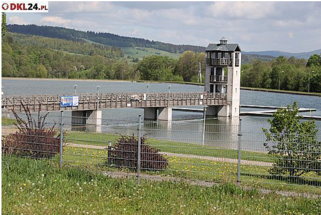
Magnezem na potencjalnych inwestorów jest zalew w Starej Morawie
